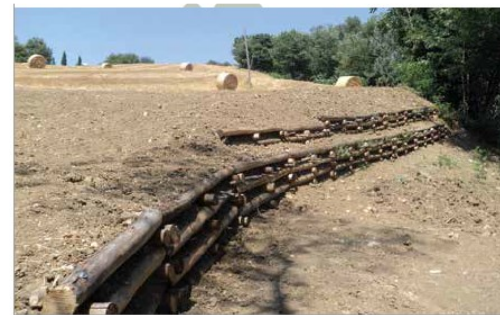
Foto 3 - Le strutture possono essere posizionate in maniera da assecondare la curvatura del versante sistemato.
