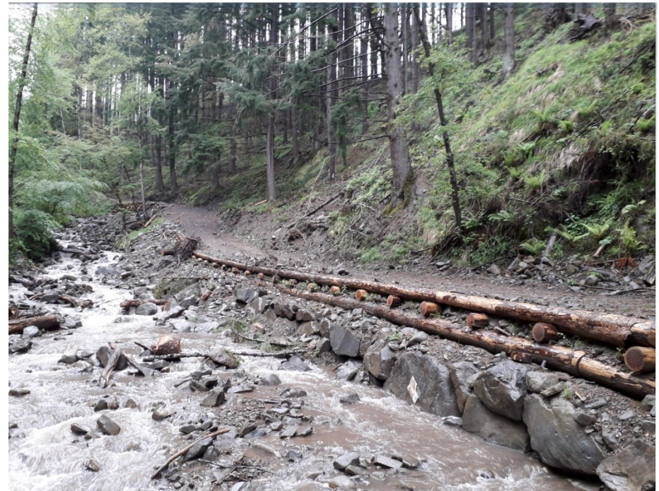
Foto 14 b – scogliera di protezione durante una piena (stato antecedente in Foto n. 7 e 8)
