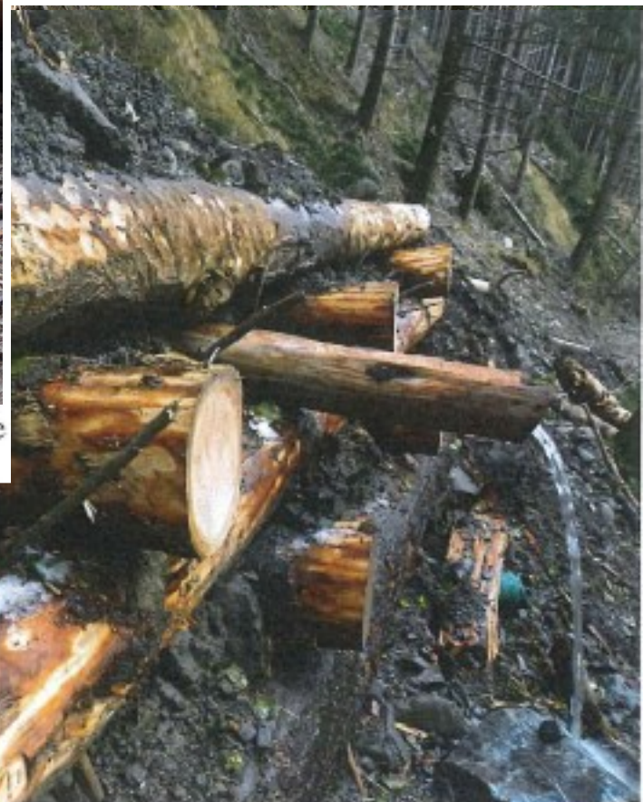
Foto 19 a – palificata per protezione al piede della strada: particolare del drenaggio sotto-strada in funzione
