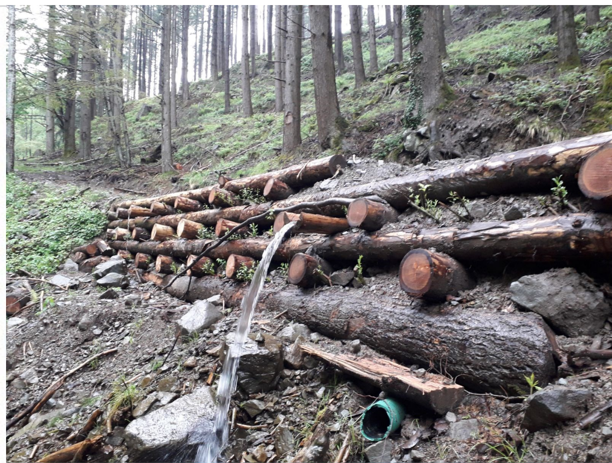
Foto 19 b – palificata per protezione al piede della strada: attecchimento delle talee (stato antecedente in Foto n. 6)
